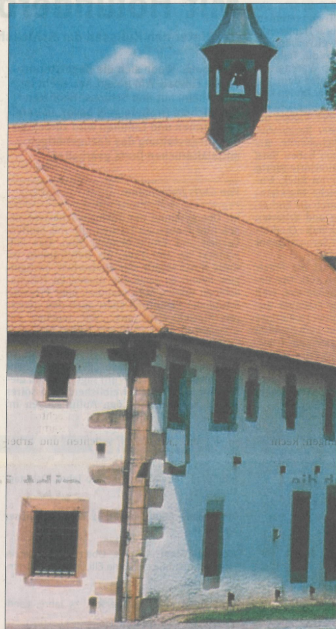
Das Haslacher Kapuzinerkloster – ein Vorbild für die Sanierung de
